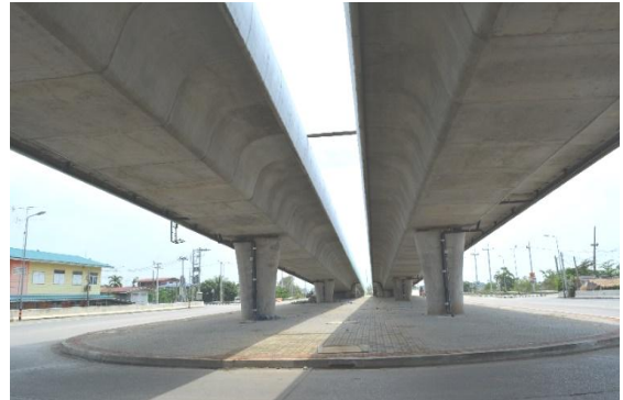
รูปที่ 8 ตัวอย่างรูปสะพานคอนกรีตอัดแรงชิ้นส่วนสำเร็จรูปหน้าตัดรูปกล่อง
