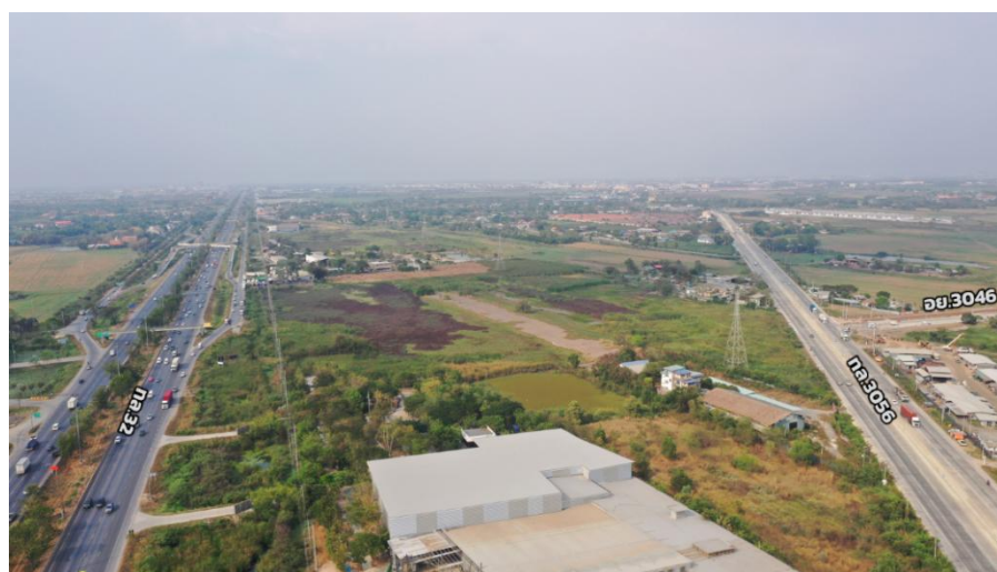
รูปที่ 5 สภาพพื้นที่โครงการ บริเวณจุดตัด ถนน อย.3046 (ถนนเลียบบคลอง 4 ขวา) กับถนน ทล.3056 (ถนนจอมพล ป.) และ ทล.32 (ถนนสายเอเชีย)
