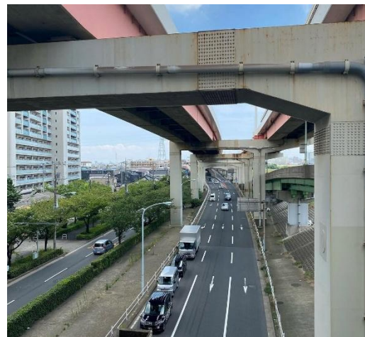
รูปที่ 8 ตัวอย่างรูปสะพานคอนกรีตอัดแรงชิ้นส่วนสำเร็จรูปหน้าตัดรูปกล่อง
