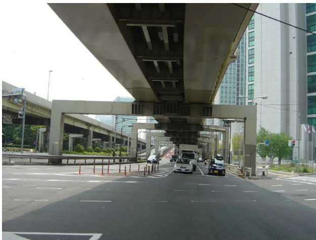
รูปที่ 8 ตัวอย่างรูปสะพานคอนกรีตอัดแรงชิ้นส่วนสำเร็จรูปหน้าตัดรูปกล่อง
